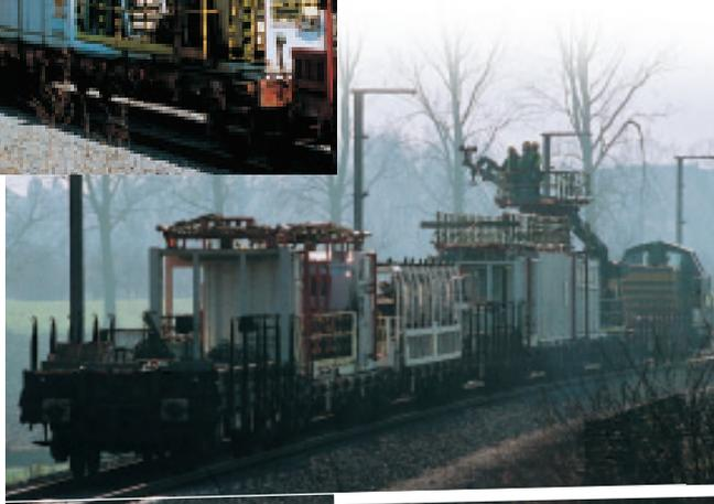
Les équipes placent d'abord les poteaux de la caténaire. L'ensemble supportera ensuite un câble porteur qui soutient et alimente le fil de contact en cuivre et transmet les 25.000 volts nécessaires à l'alimentation du TGV.
