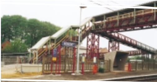
De moderniseringswerken brengen in Herent niet enkel twee extra sporen, maar ook een vernieuwde halte met modern aangeklede perrons.
