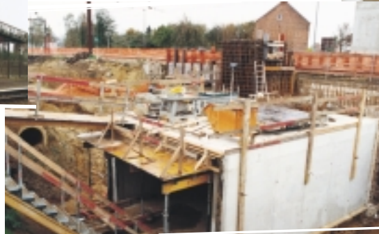
De nieuwe onderdoorgang zal doorlopen tot onder de Spoorwegstraat.
