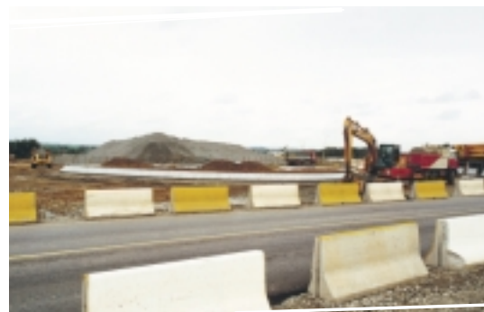
Aan het op- en afrittencomplex 25 in Tienen wordt een rotonde aangelegd.
