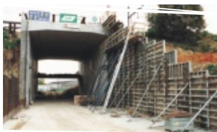
De nieuwe tunnel aan industriezone van Zaventem is de grootste koker die ooit in België onder de sporen is geperst.
