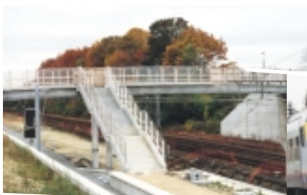
De fietsers- en voetgangersbrug tussen de Parklaan en de Steenokkerzeelbrug zorgt voor een vlottere verbinding en biedt een snelle toegang tot de perrons.
