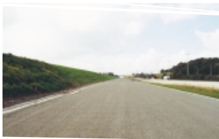
De werken burgerlijke bouwkunde zijn intussen achter de rug. Alles ligt klaar om de spooruitrusting aan te brengen.
